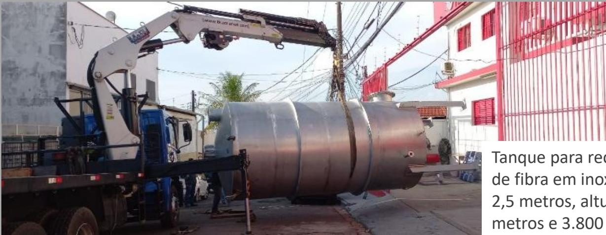
Tanque para reciclagem de fibra em inox 304: Ø 2,5 metros, altura 5 metros e 3.800 kg
